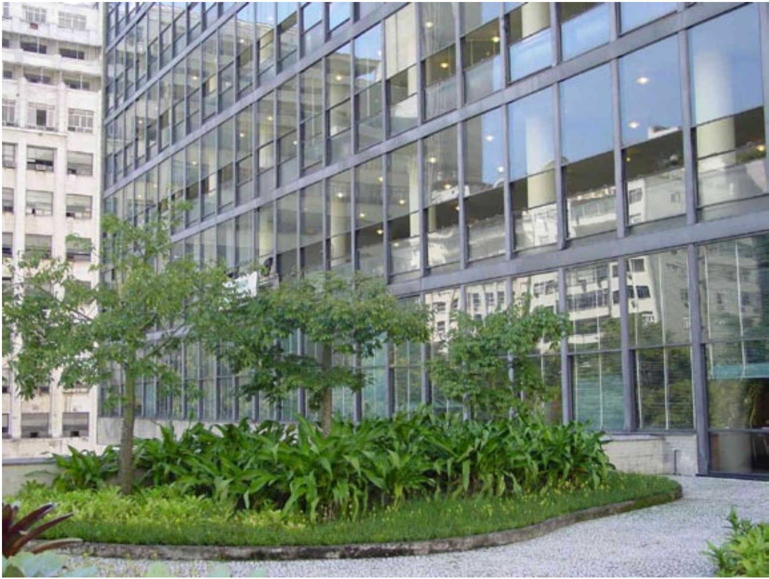
FIG. 3. DETALLE DE LA FACHADA SSE.
