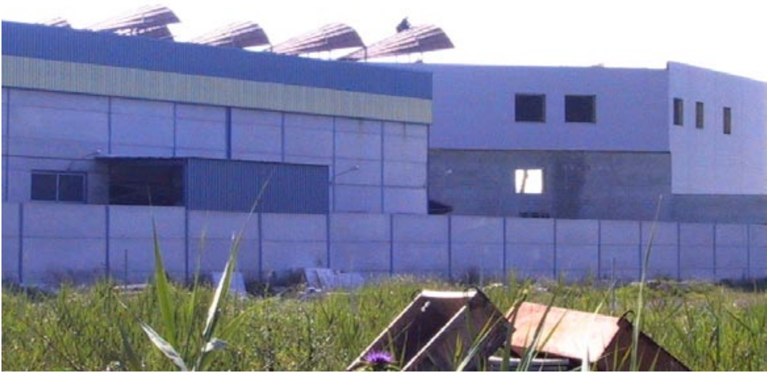
FIG. 20. LUCERNARIOS DE EDIFICIO DE OFICINAS EN GELVES. J. M. ALMODÓVAR, 2004.
