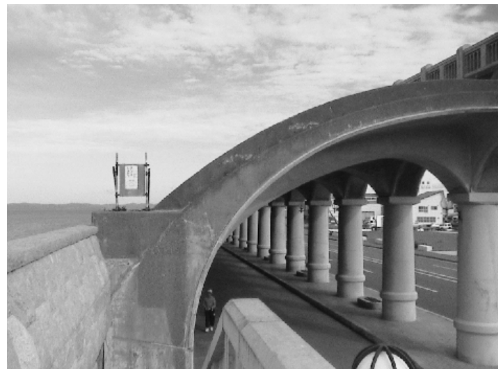
Fig. 11. Recent view of Wakkanai break-water dome (Hokkaido). Vista reciente del Wakkanai break-water dome (Hokkaido).
