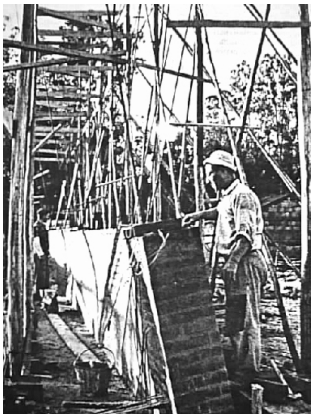
Fig. 15. The initial stage of the construction of the conoidal walls of Atlantida Church. Inicio de la construcción de las paredes conoidales de la Iglesia Atlántida.
