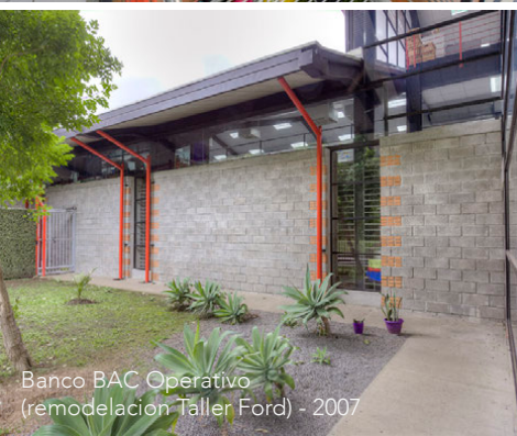
Banco BAC Operativo (remodelación Taller Ford) - 2007
