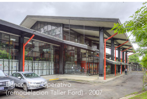
Banco BAC Operativo (remodelación Taller Ford) - 2007
