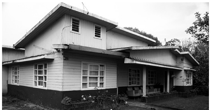
Fig. 24. Vivienda en Zarcero, camino a San Carlos.
