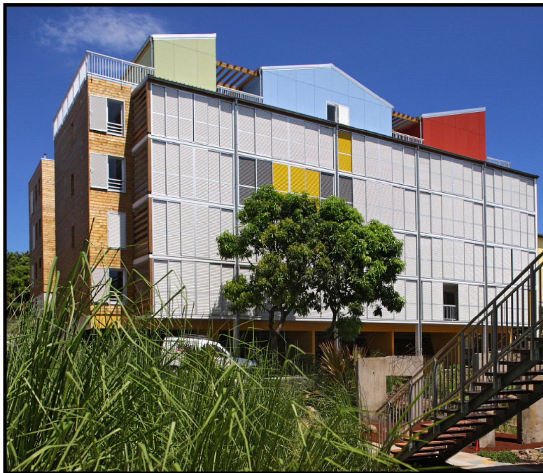
Ventilation Traversante: détail volets persiennés Ventilación cruzada: detalle de postigos/persianas
