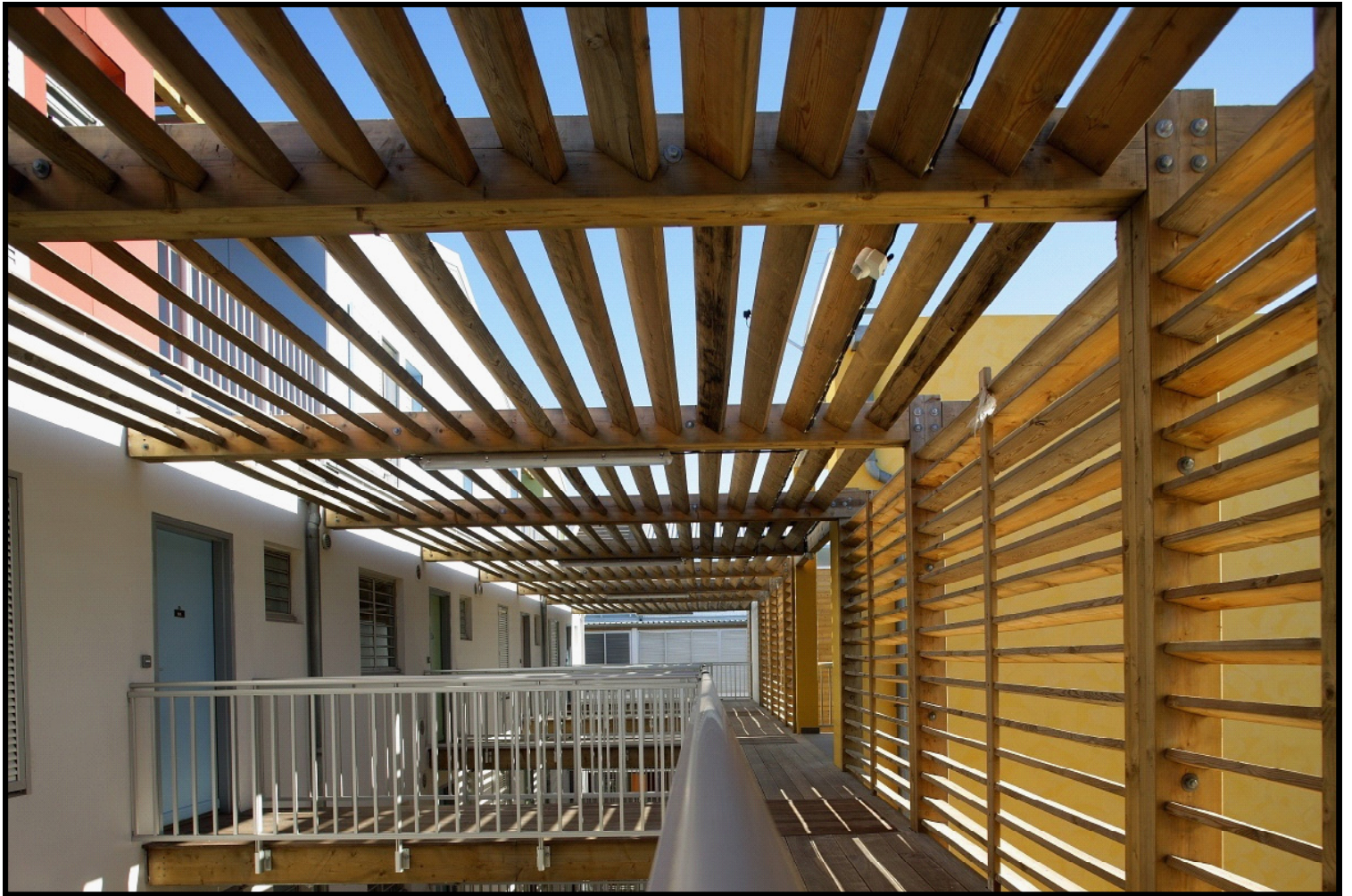
Protection solaire: doubles peaux ventilées bois sur façades béton
