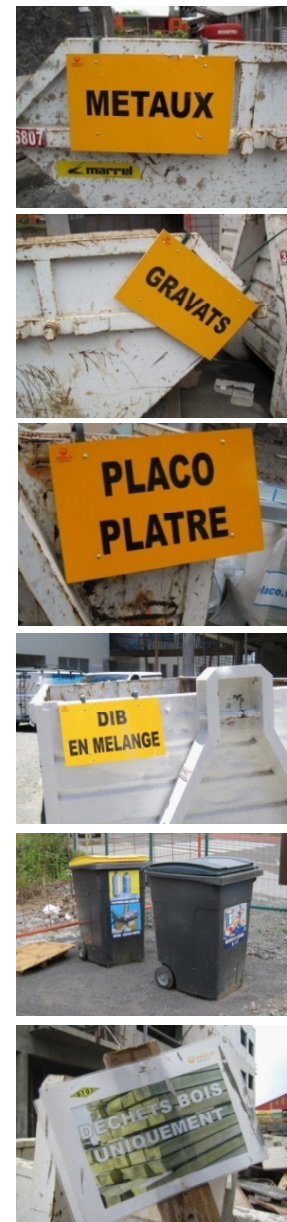
Tri sélectif des déchets de chantier / Clasificación selectiva de los desechos en la obra.
