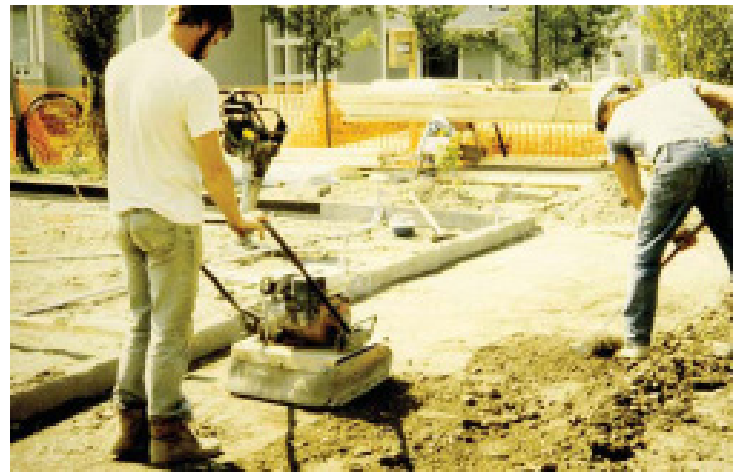
Fig. 1.2 La compaction est indispensable pour atteindre la capacité portante pour les trottoirs / La compactación es indispensable para lograr la capacidad portante en las aceras.
