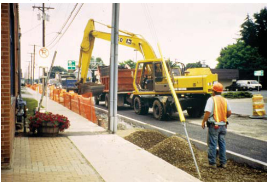
Fig.1.9 L'installation du CU-Sol Structural MD à Ithaca, NY, en 1997 / Instalación de CU-Structural Soil TM en Ithaca, NY, en 1997.
