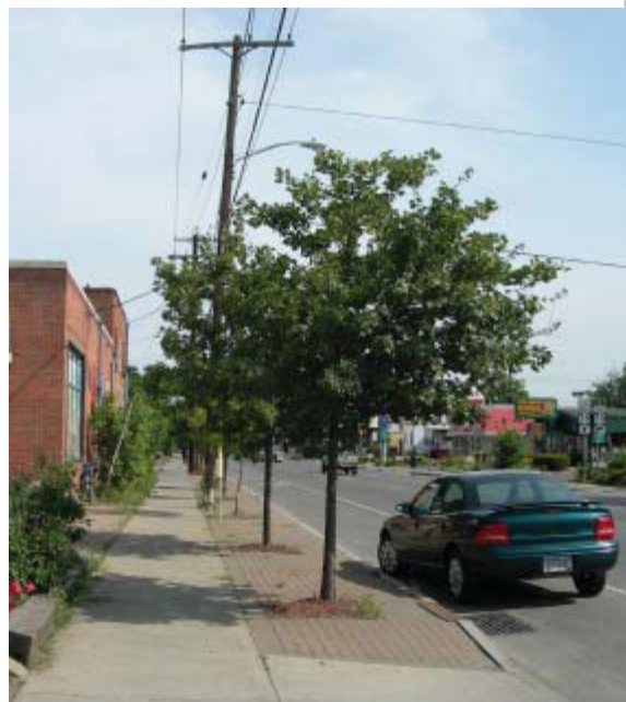
Fig. 1.24 Pavé de béton sur un lit de pose en sable grossier ou petites pierres calibrés en surface d'une fosse continue de CU-Sol Structural MD à Ithaca, NY / Losas de concreto sobre una cama de arena bruta y piedra pequeña calibrada en la superficie de una fosa continua de CU-Structural Soil TM .
