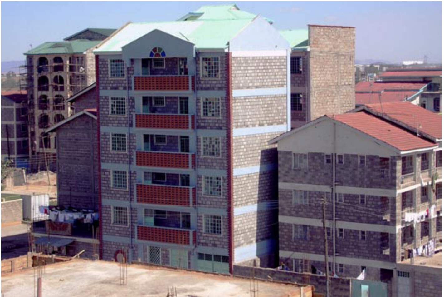
Figure 7. Tenement housing Nairobi / Casas de alquiler, Nairobi. (Source /Fuente: Marie Huchzemeyer 2007).
