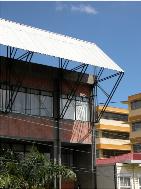
Edificio de oficinas Ambos Mares 1988
