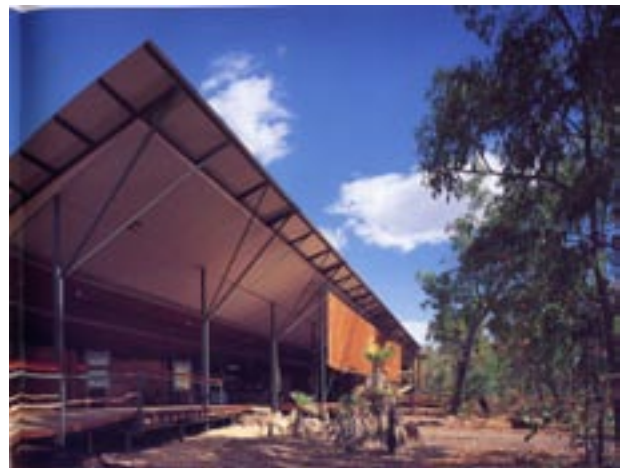
Centro de Información para Visitantes, Bowali, Parque Nacional, Kakadu , arq. Troppo y Glenn Murcutt, Australia.
