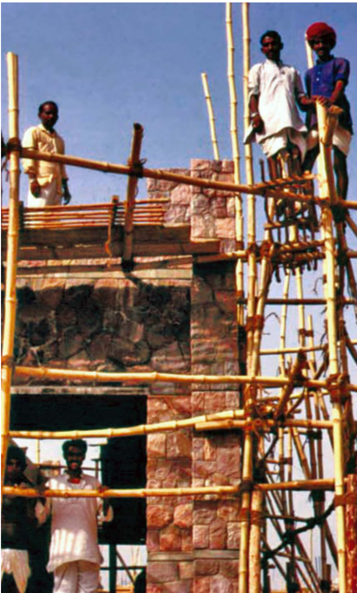
Fotografía: Instituto Indio para la Salud en construcción. Arquitecto: Ashok Lall. Photo: Indian Health Institute under construction. Architect: Ashok Lall.
