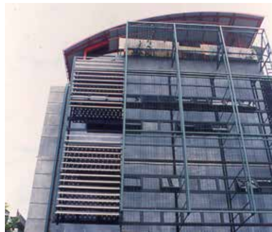
El edificio en construcción. Instalación de las pantallas
