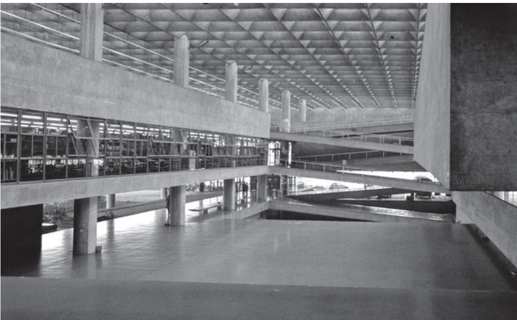
Edificio de la Facultad de Arquitectura y Urbanismo, Universidad de São Paulo. Joao Batista Vilanova Artigas, (1962-1969). 1976.
