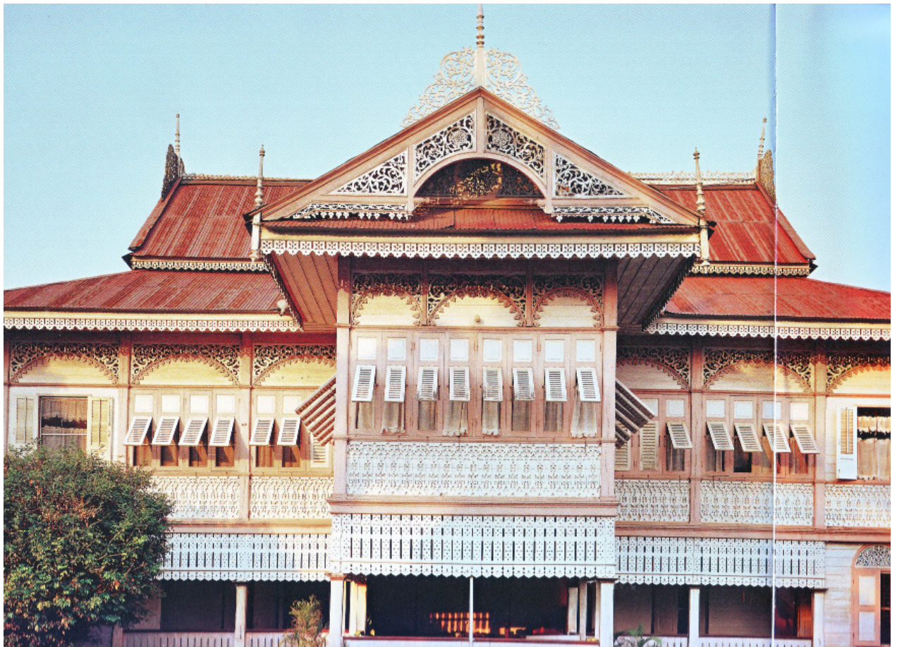
VONGBURI HOUSE, Prachinburi, Tailandia. Construida en 1907 para Luang Phongphibul por un constructor chino de Canton, quien contrató mano de obra local para su ejecución. La casa aún pertenece y es habitada por la misma familia. Construida en teca, todos los calados (fretwork) son originales. Lo único que se reemplazó fueron las tejas de teca y se reemplazaron por latas de zinc.
