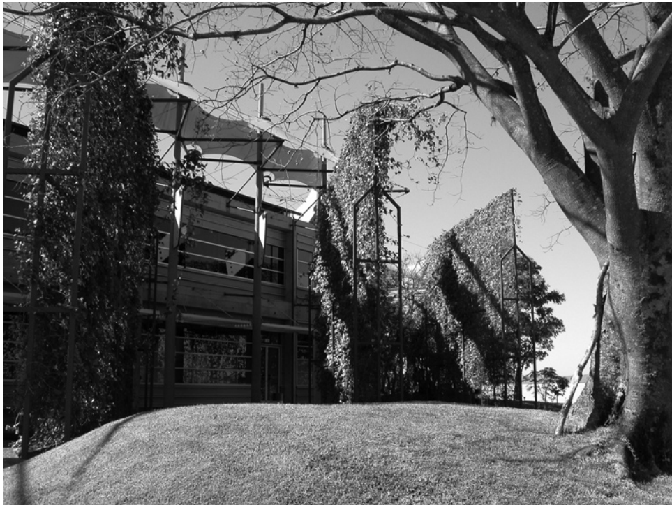
Edificio HOLCIM Costa Rica, 2004. Elementos pasivos en los edificios bio- climáticos: agua, aleros, telas, pantallas y vegetación / Holcim Costa Rica Office Building. Passive elements for the bio- climatics buildings: water, eaves, brise soleil and vegetation.
