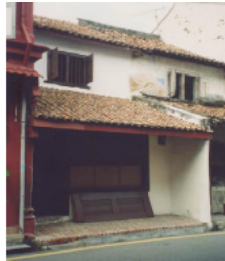
Fig. 15: Conservation work / Trabajo de conservación.
