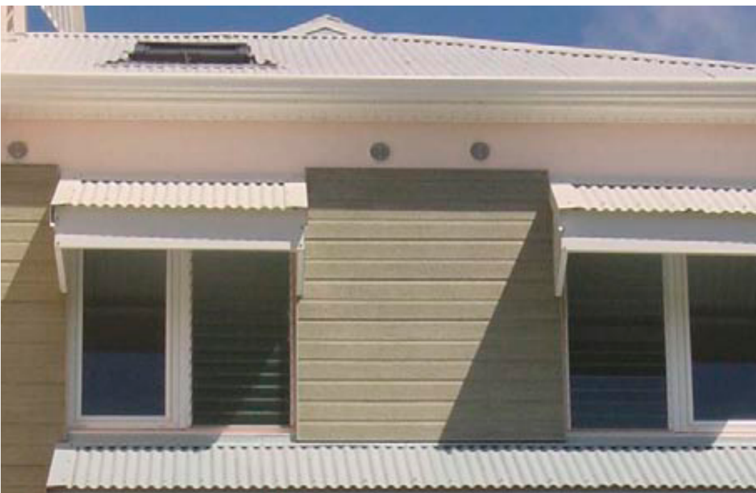
Ventana a la sombra de aleros Fenêtres à l'ombre des pare-soleil
