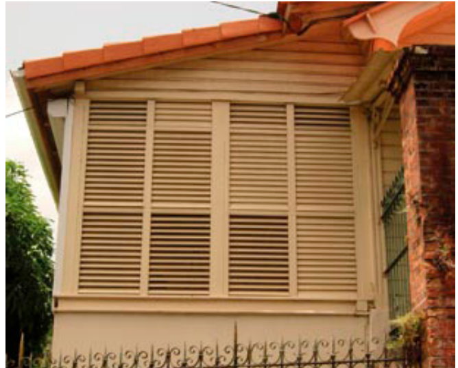
Panneau de lames ventilantes (persiennes) Panel de persianas
