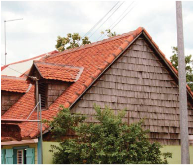
Double peau en bardeaux bois (essentes) Doble piel en tejas de madera de burdiégamo
