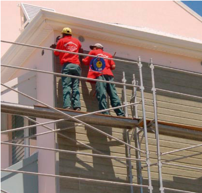
Pose d'un bardage ventilé Instalar una protección ventilada
